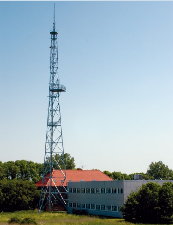
Service Center Gebäude der VCS in Norddeich
